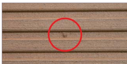
Dépôt naturel de fibres avant traitement
